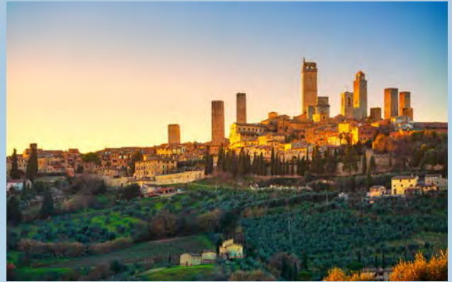
Anders als in Lucca, Florenz oder Pisa blieben in San Gimignano einige der mittelalterlichen Geschlechtertürme bis heute bestehen.
